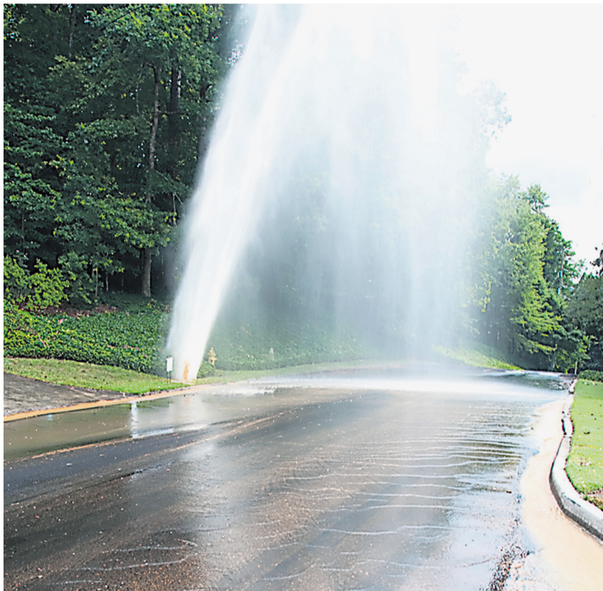
Frühzeitige Erkennung und Reparatur von Leckagen vermindern grössere und gefährliche Lecks. Foto: iStock
